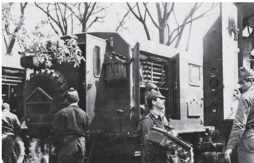
A hírközpont telepítése
