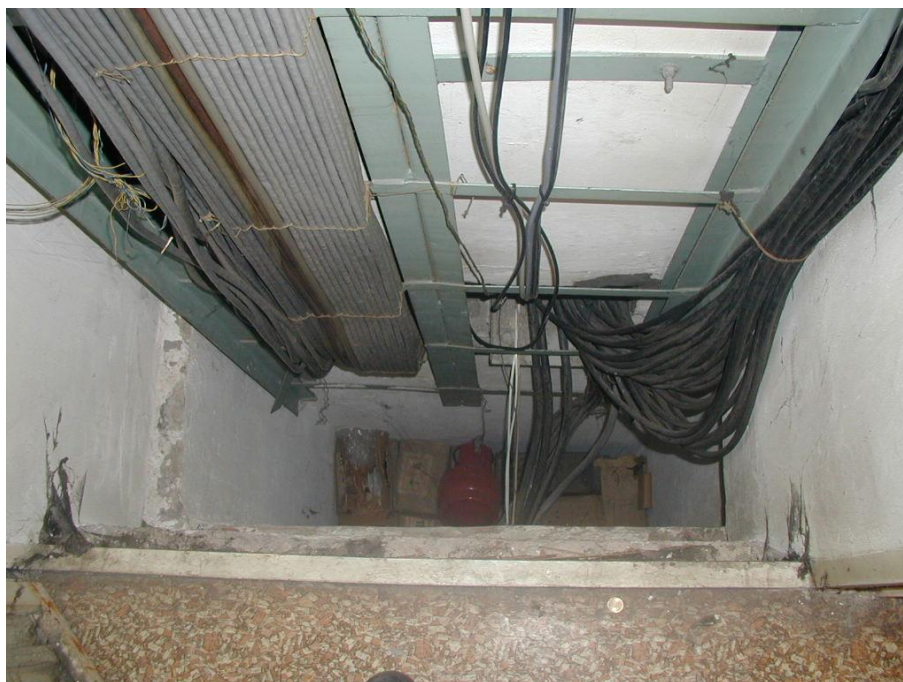
Az AR kábel felvezető akna felülről
