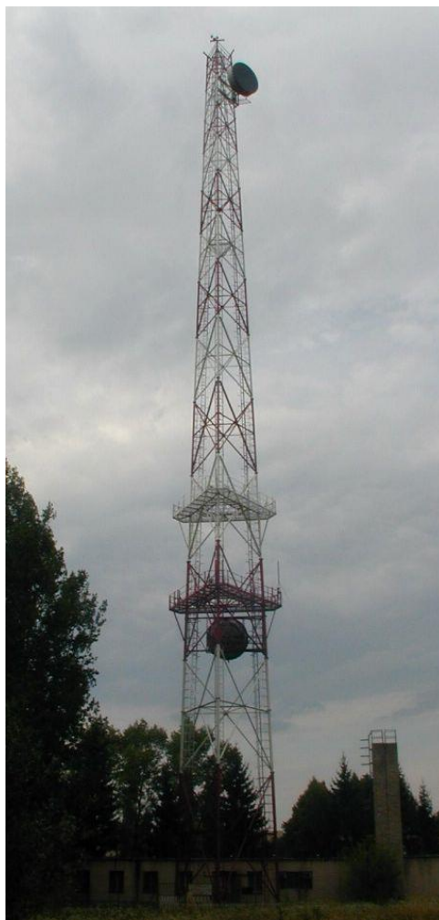
Két erkély, URH antenna, Görbetető felé a parabola A torony felső antennája Kaposvár felé
