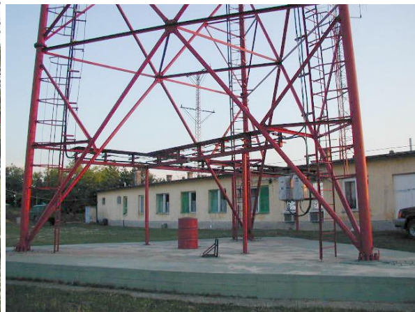
74 méter magas torony terpesztése az alapon 84 méter magas torony terpesztése az alapon
